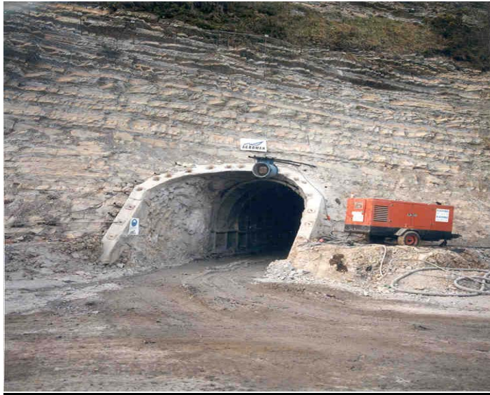
* Túnel y Emisario Jaizkibel
