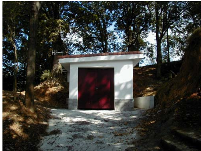
* Estación de Bombeo de San Marcial
