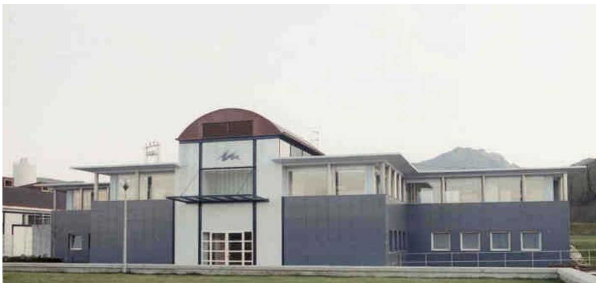
* Imagen frontal de la Estación de Tratamiento de Aguas Potables (ETAP).
