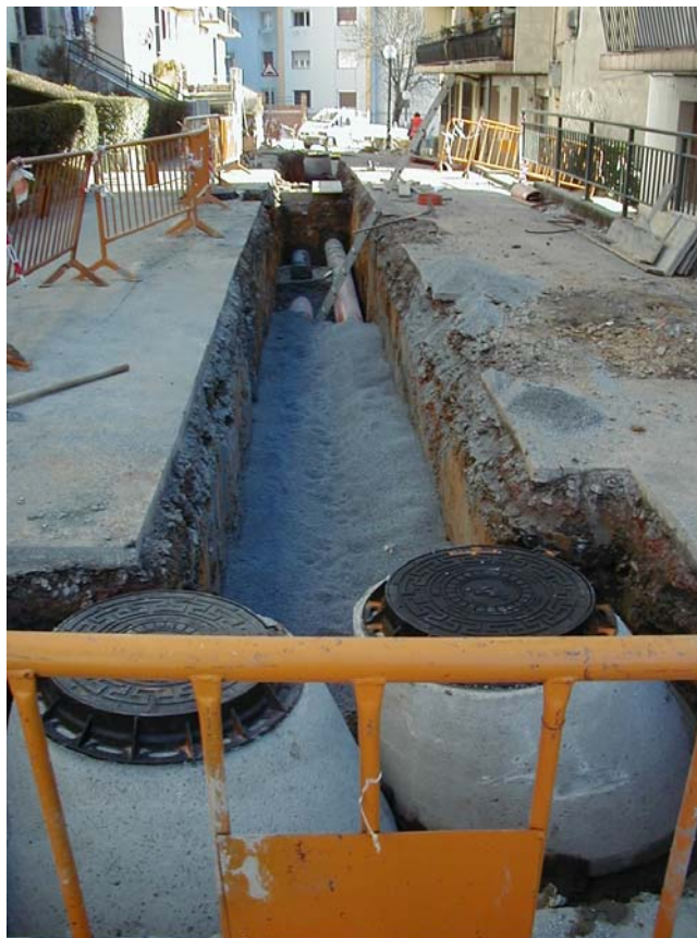
* Obras calle San Francisco Javier
