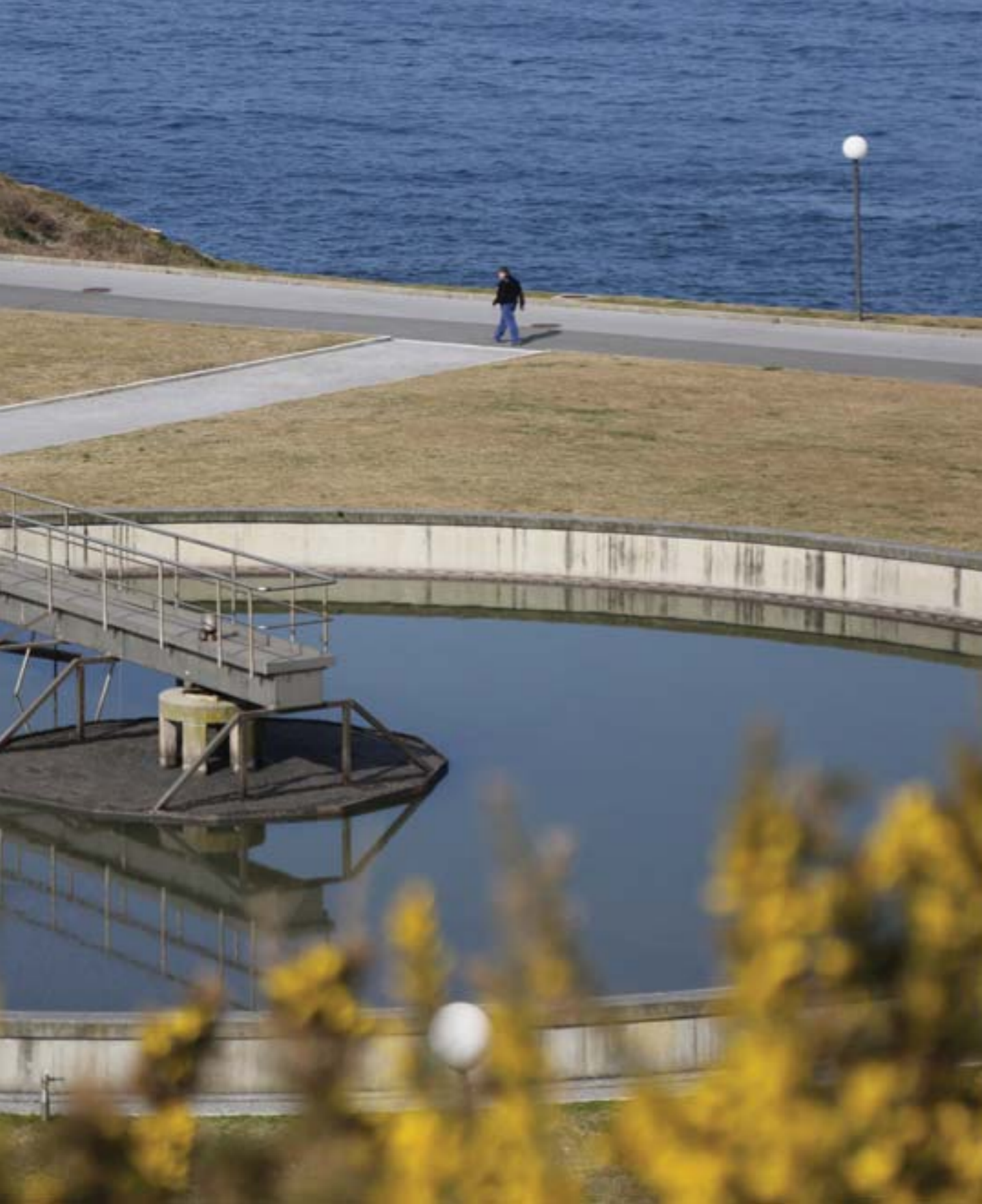
Decantador para fangos en la estación de Atalreka
