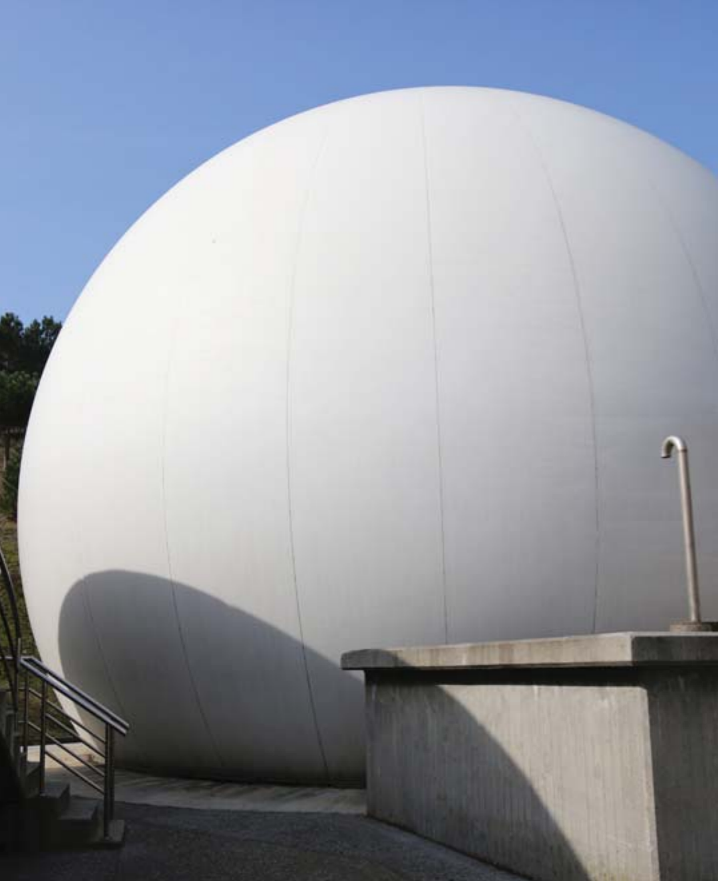
Gasómetro para la acumulación del biogás generado en el proceso de digestión de fangos
