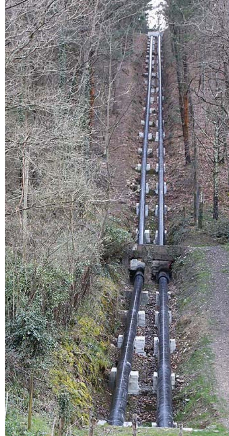
Tramo de la conducción renovada del salto de Irugurutzeta
