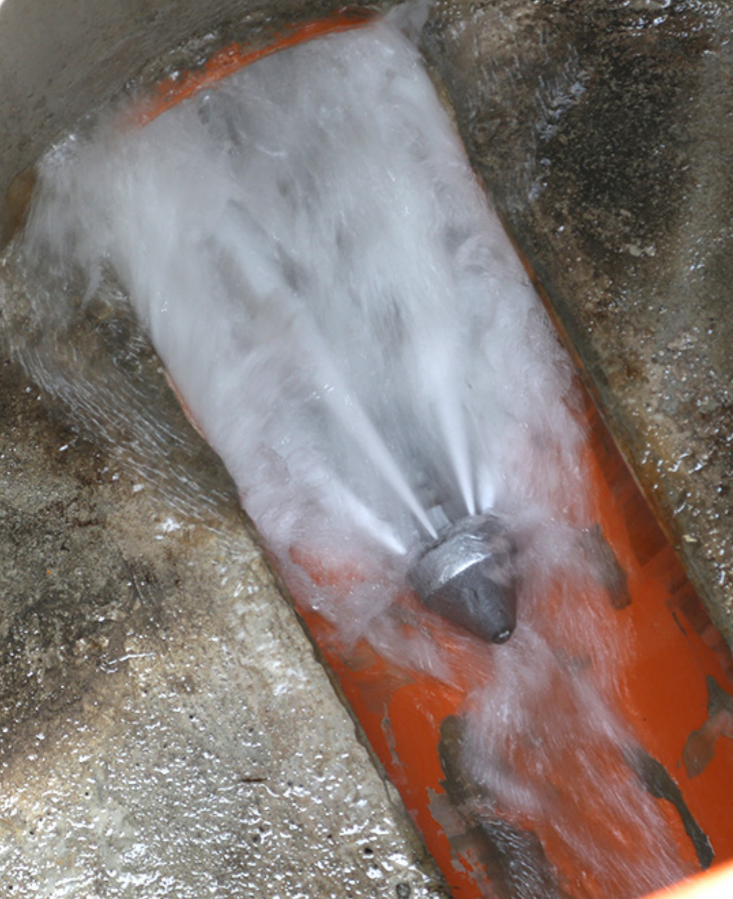
Granada de agua a presión para limpieza de colectores
