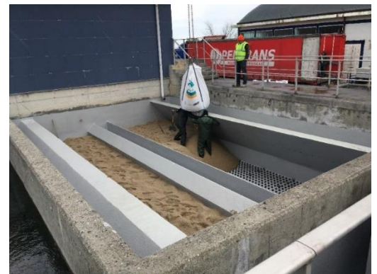
Relleno lecho filtrante
