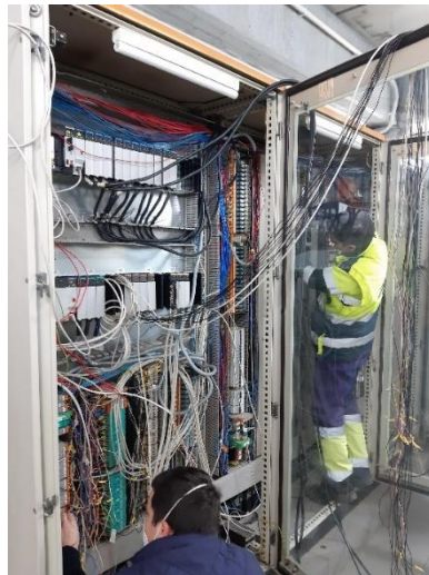
Sustitución del plc EDAR2
