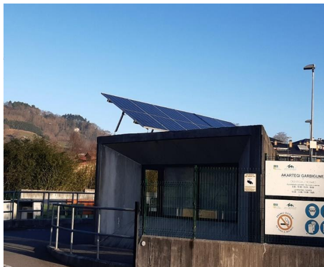
Instalación fotovoltaica del garbigune de Akartegi
