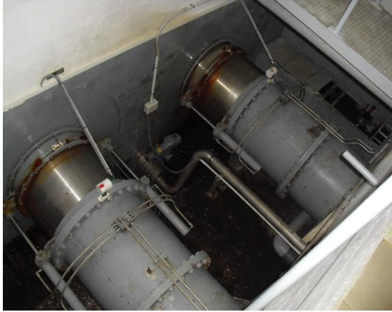
Válvulas antes de la intervención
