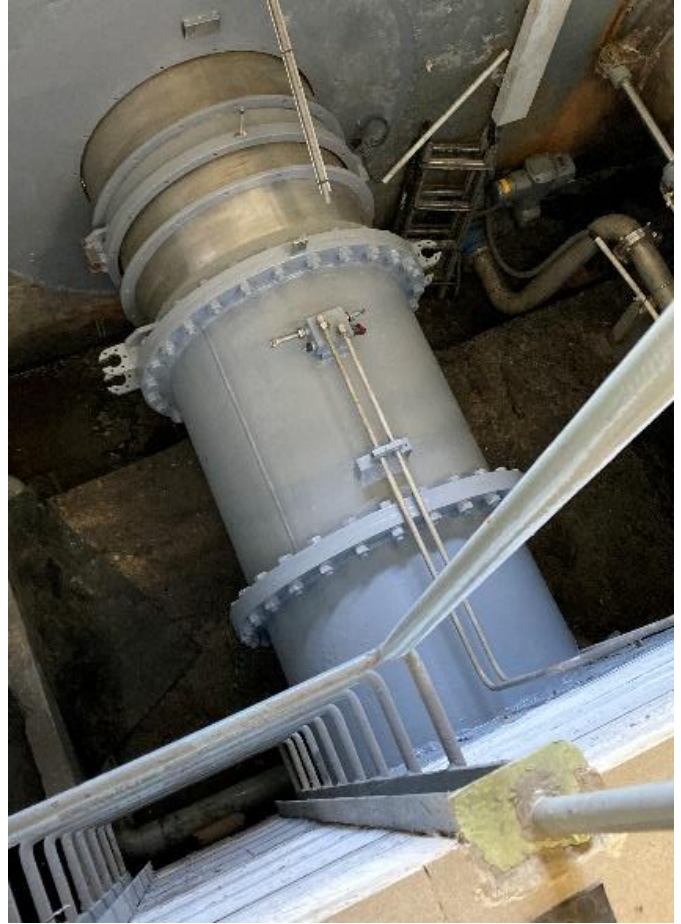
Válvula después de la intervención
