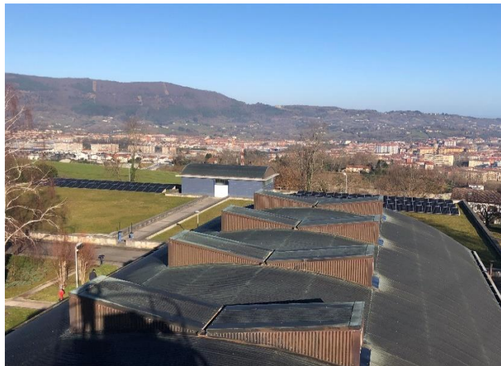
Paneles solares ETAP Elordi
